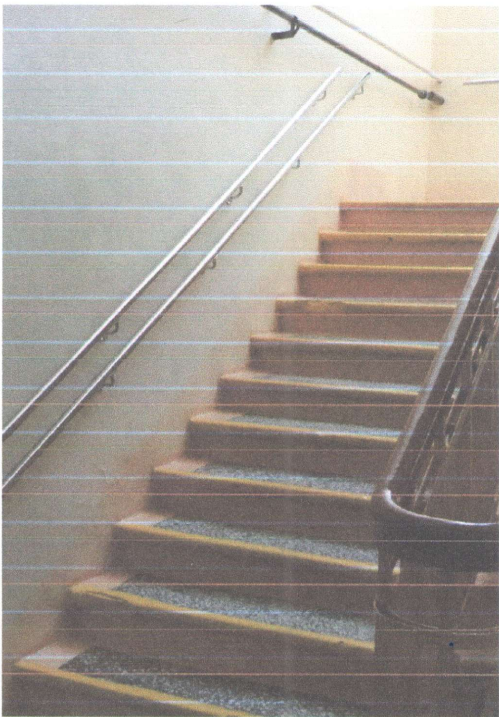
Фото 15 Пандус (внутри здания отсутствует)
