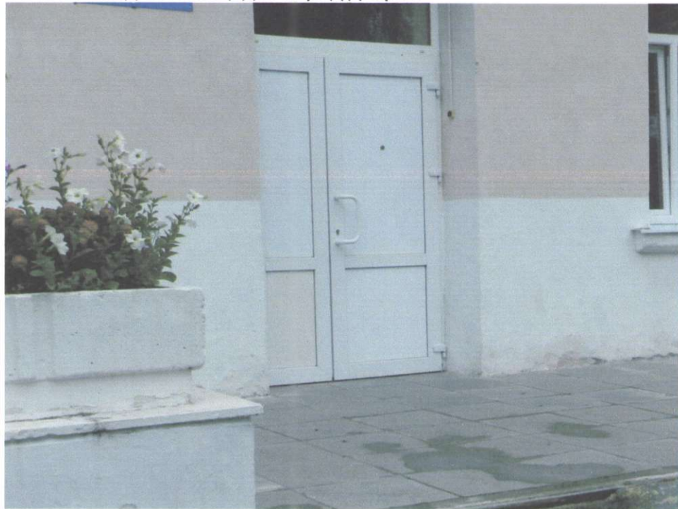
Фото 10 Входная площадка перед дверью
