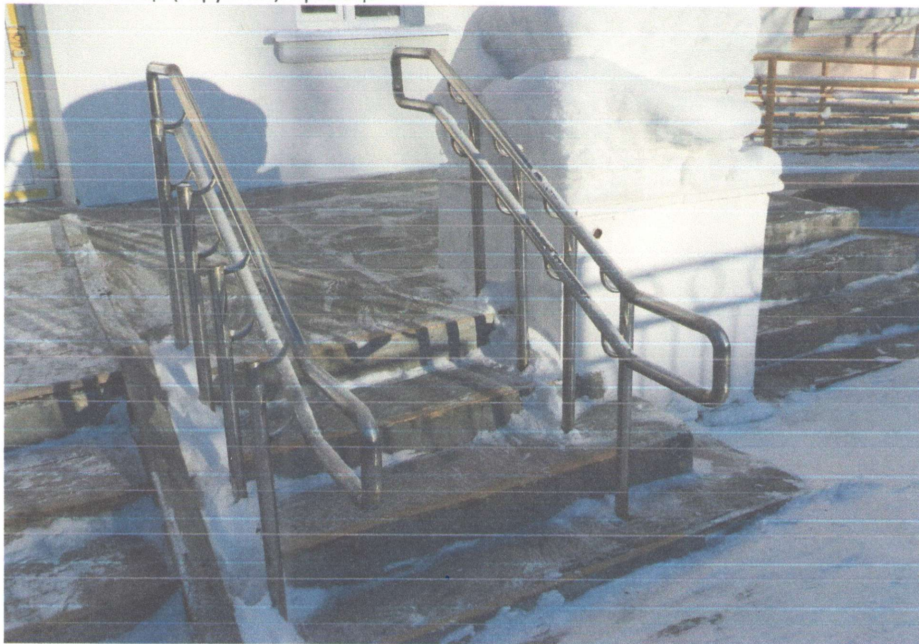
Фото 8 Лестница (наружная). Крыльцо.
